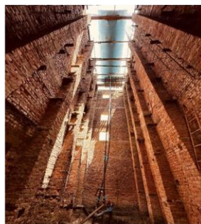
МУП ЖКХ «Корсунское» ст. Старокорсунская, ул. Чонгарская, д.б/н
